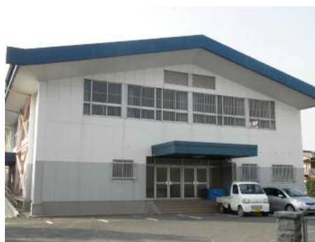
小学校（屋内運動場）
